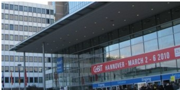
Hala głównego wejścia na Targi (źr. Wikipedia)
